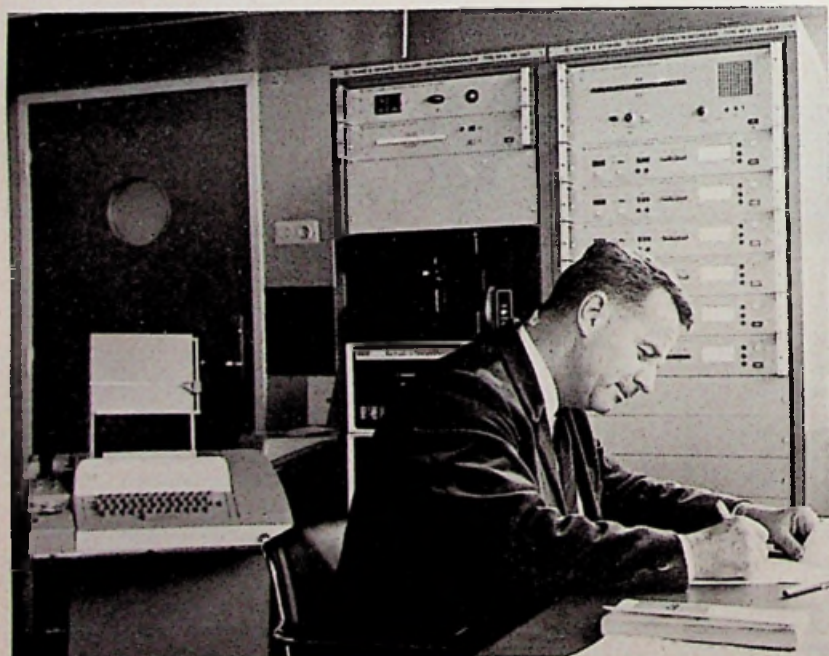
Afb. 7. Centrale post van de geluidsmeetinstallatie Schiphol. Rechts de zes frequentie/niveau-omzeters, in het midden de computer, links de teletype.
