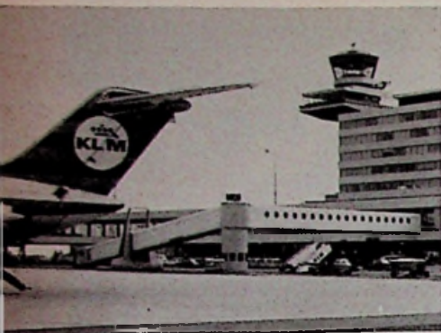
Links: afb. 4. Luchthaven Schiphol. De centrale geluidsmeetinstallatie bevindt zich op de toren voor de verkeersleiding.
